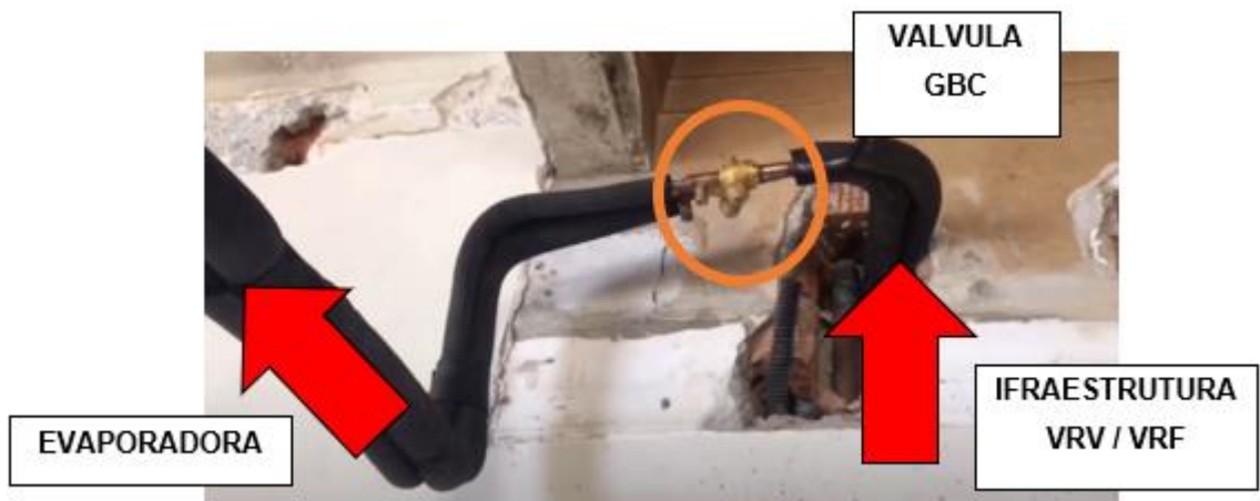
Válvula tipo GBC em uma linha frigorígena.
